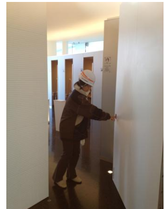
混雑状況に合わせてトイレを区切る仕切り壁。
