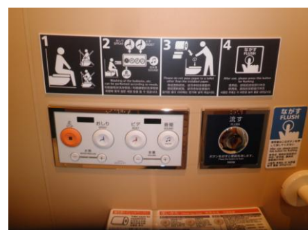
使い方を書いたピクトサイン。温水洗浄便座の操作ボタンや洗浄ボタンもまとめた。
