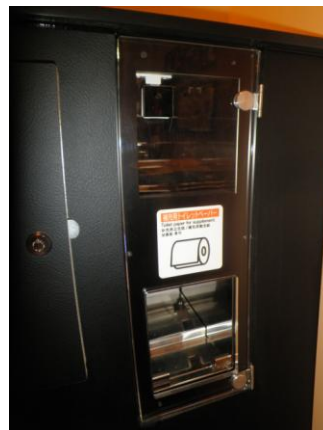
センサーで反応して、交換用の紙が出てくる新システム
