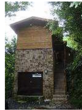
屋久島の縄文杉登山道のトイレ: 環境に負荷を与えないトイレとして活躍。運搬はトロッコ列車で行ったそうだ。
