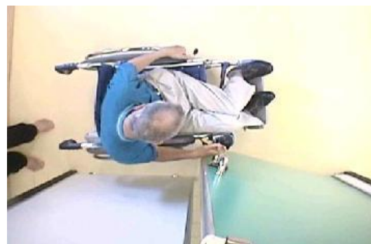
電動車椅子の方は、外開き戸を開ける事が困難ですが、折れ戸なら開閉が可能です。
