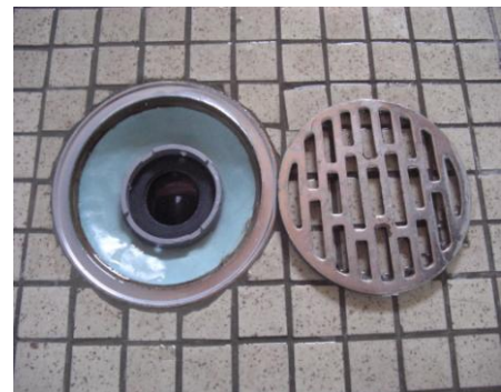
A案：床排水金物エコ修繕の変更写真
