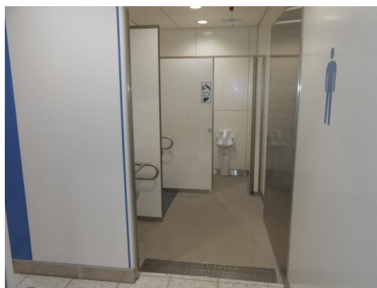
国会議事堂前駅「切り替えトイレ」は、空間に制約はあるものの、効率の良いメンテナンスができるので好評。
