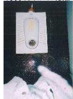
(写真3)手前に排水口がある便器
