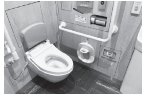
男性トイレには、埋め込み式のサニタリーボックスが装備されていた(補助便座右部)
